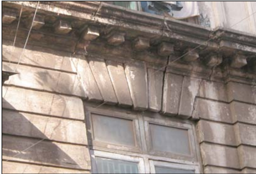
Figure 19 Voussoir crack
